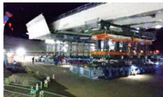
多軸式特殊台車による一括架設
