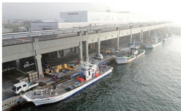
屋根付き岸壁での陸揚げ状況
