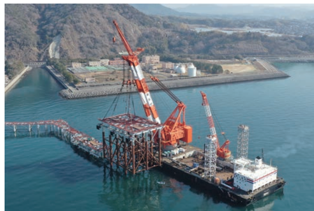
ジャケット据付状況
