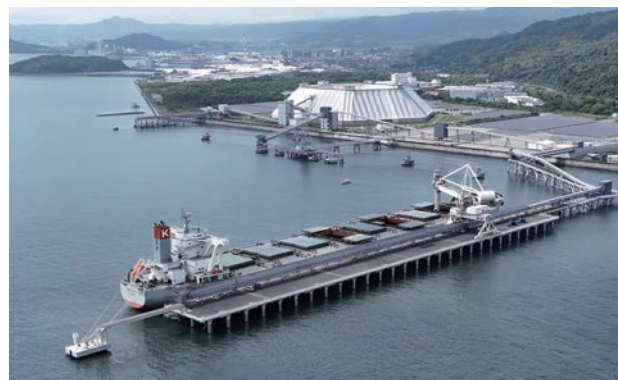
ケーブサイズ船が着桟し荷役する様子
