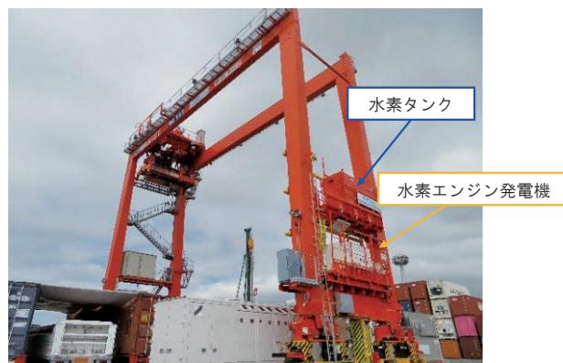
水素エンジン発電機換装RTG 全景
