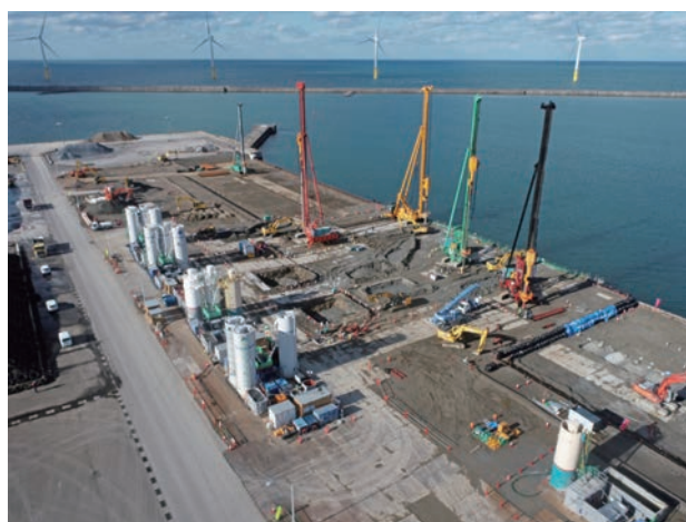
深層混合処理工法による施工状況
