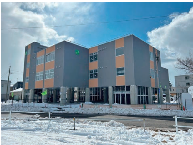
津波避難タワー（いづみ公園）
