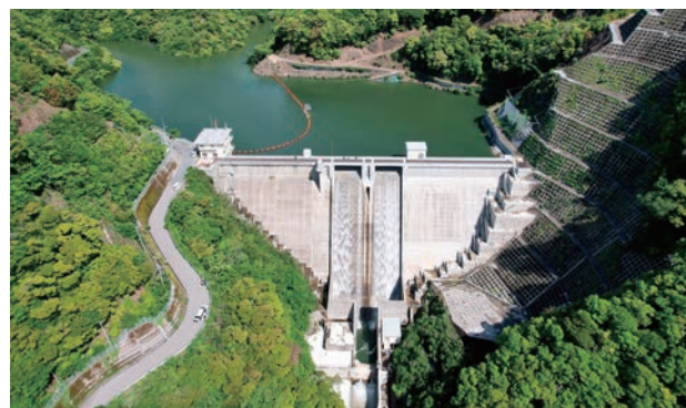
洪水時最高水位到達時の和食ダム（令和7年5月）
