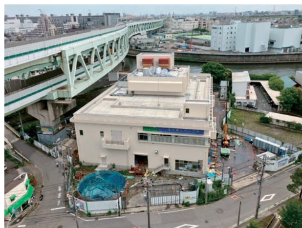
王子第二ポンプ所（全景）
