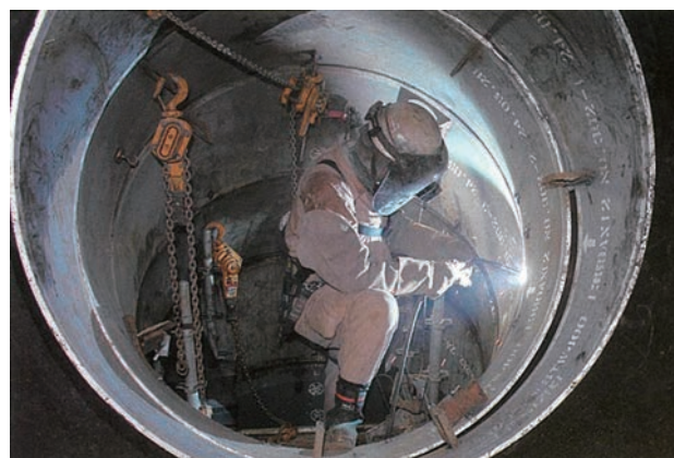
垂直配管における溶接状況
