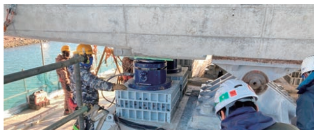
耐震工事中（支承取替工）
