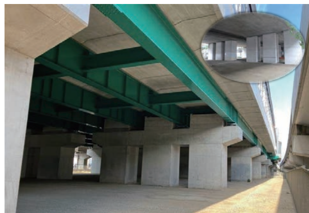
RC中空床版橋の更新
