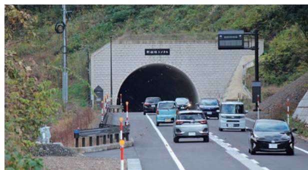
新板垣トンネルの通行状況（越前市側）
