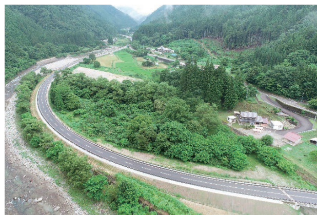
完成した黒石3工区
