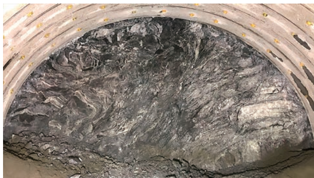
中央構造線によってもまれた切羽状況
