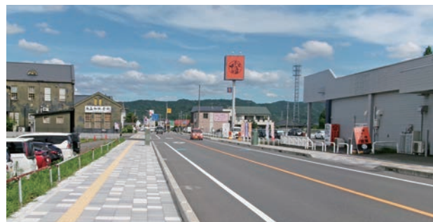
中央工区全景
