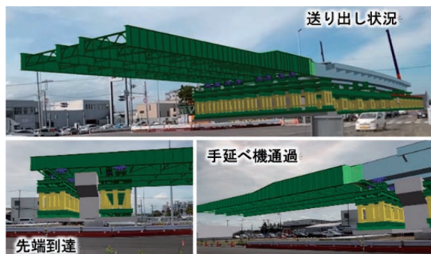
送出し架設のMRシミュレーション
