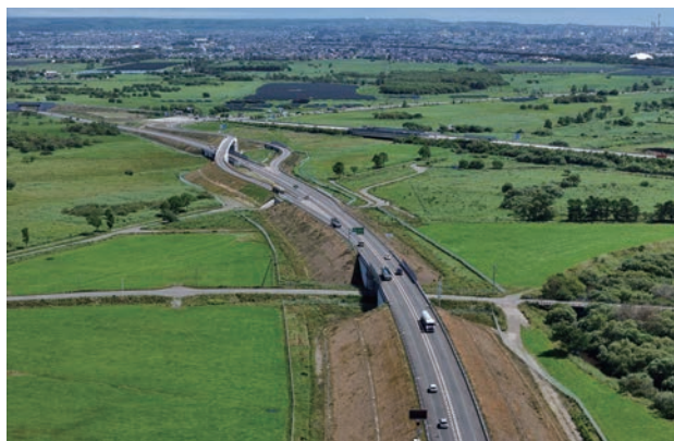
開通後の釧路西IC付近
