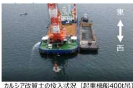
写真-2 深掘跡地でのグラブバケット による改質土の試験投入の状況
