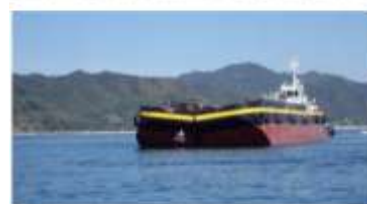
カルシア改質土の投入状況1回目 (全開バージ船1300m 3 積級)
