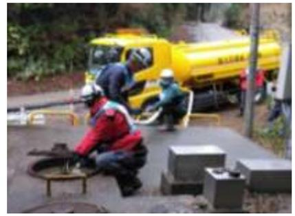
上水道施設漏水点検用の給水
