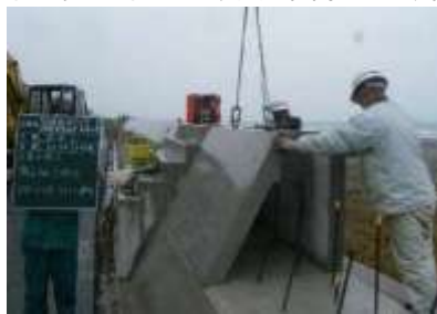
写真(k)ー1 従来工法(施工が煩雑) 写真(k)ー2 プレキャスト化により施工を効率化 写真(k)ー3 プレキャストパラペット完成近景
