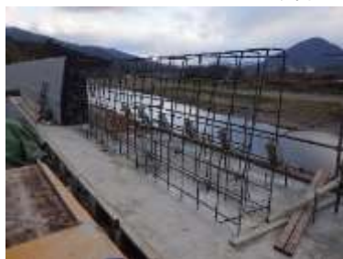
写真(k)ー1 従来工法(施工が煩雑) 写真(k)ー2 プレキャスト化により施工を効率化 写真(k)ー3 プレキャストパラペット完成近景
