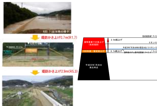
図(a)ー5 東大洲地区の堤防整備状況
