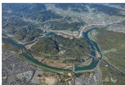
小田川合流点付替え区間全景
