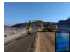
ICT施工 (締切堤防)
