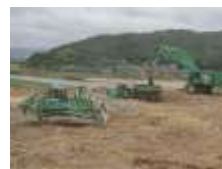
建設機械の大型化 (南山掘削)
