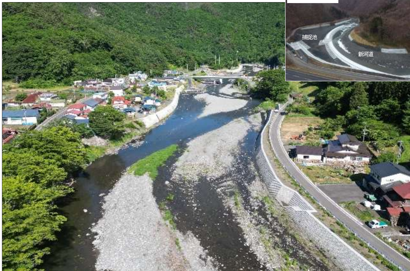
岩泉町尼額地区及び流木捕捉施設 完成状況
