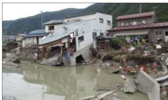
家屋被害の状況
