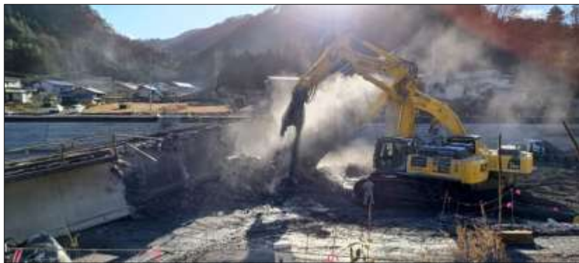
旧橋解体作業の様子
