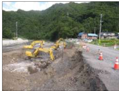
河道拡幅作業の様子
