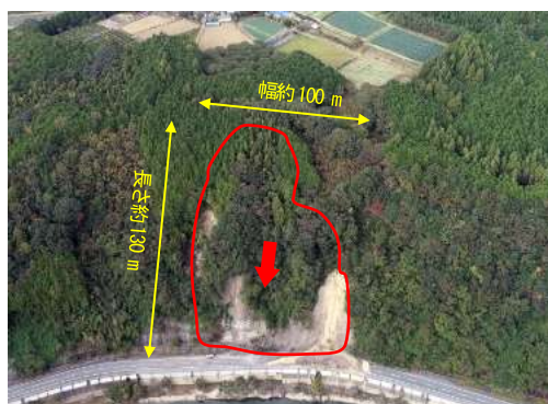
被災斜面、地すべりブロックの規模
