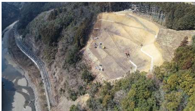
排土工施工状況
