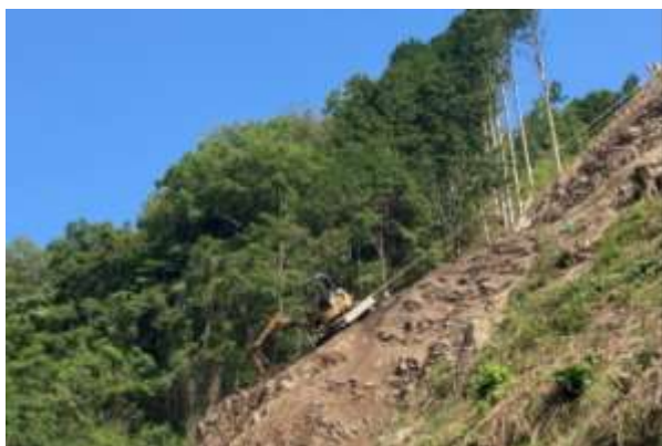
高所無人掘削工法による施工
