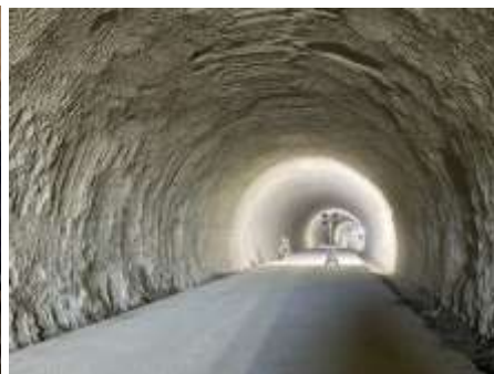
写真-8 覆工表面除去完了
