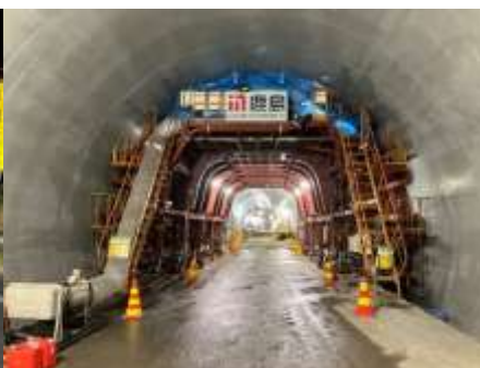
写真-2 復旧工事の様子(セトル)
