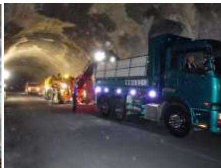
写真-11 舗装補修切削状況
