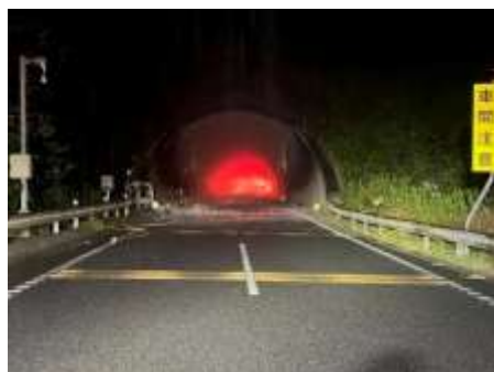
写真-1 東坑口からの火災状況
