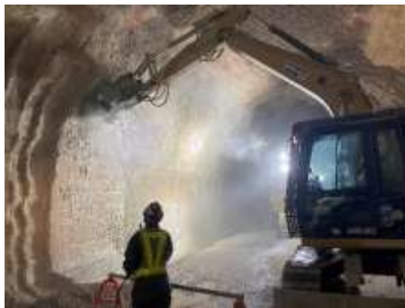
写真-7 ツインヘッダーでの切削状況
