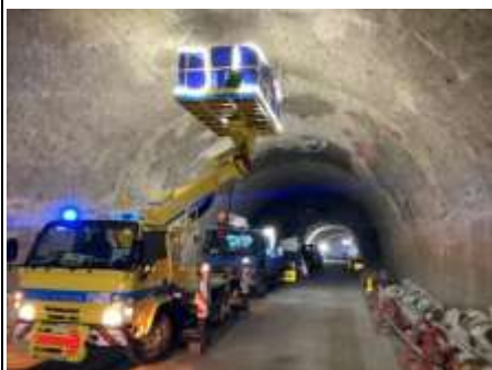
写真-6 背面空洞注入工
