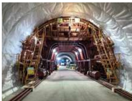
写真-10 セントル覆工打設状況
