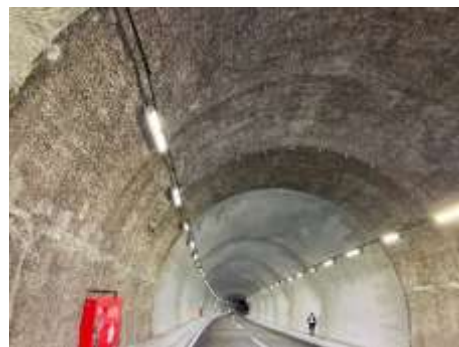
写真-12 開通前日のトンネル坑内
