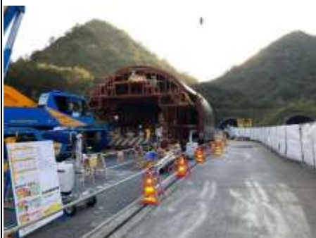
写真-9 セントル組立状況
