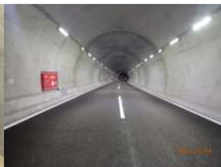
写真-3 復旧後の尼子山 TN
