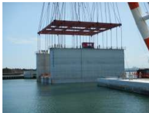
ハイブリッドピア据付状況 (締切不要のため仮設分の航路を確保! )
