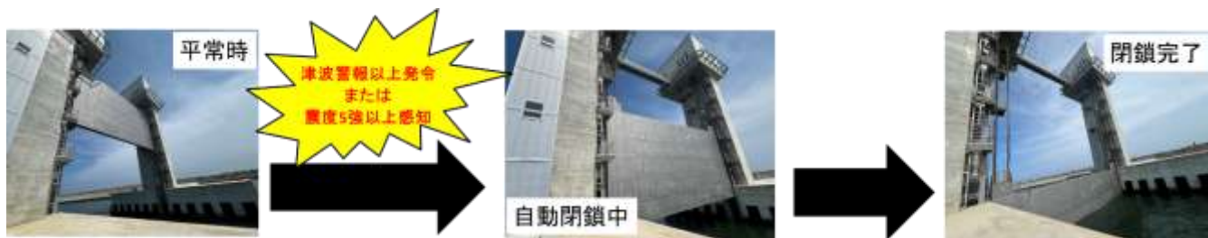
水門の自動閉鎖状況(令和6年6月撮影)
