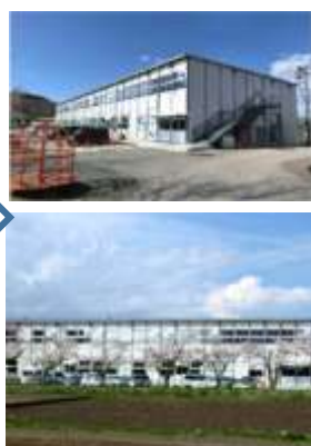
②ふたば支援学校仮設校舎 (いわき市)
