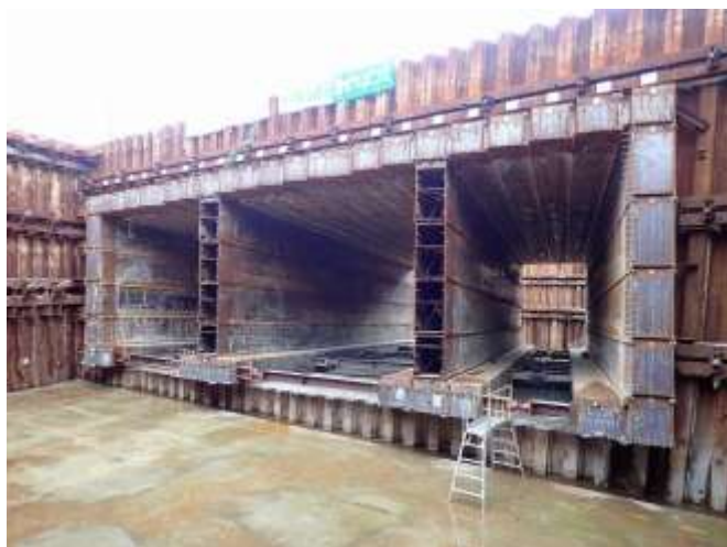
JR 常磐線アンダーパス HEP&JES 工法
