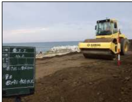
締固め管理システムによる築堤盛土
