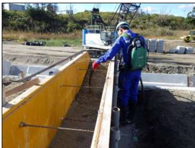
コードレス高周波バイブレーターを用いた生コン打設
