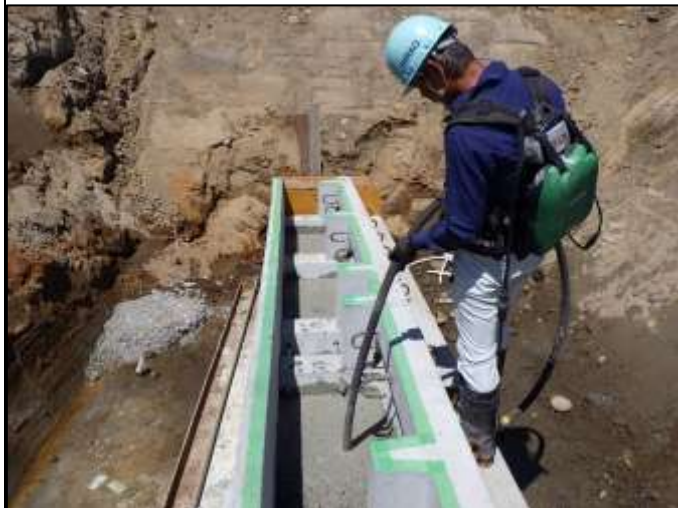
コードレス高周波バイブレーターを用いた生コン打設
