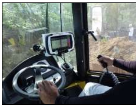
締固め管理システムによる築堤盛土
