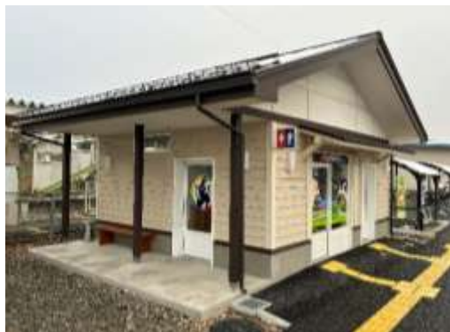
整備後〔公衆トイレ〕
