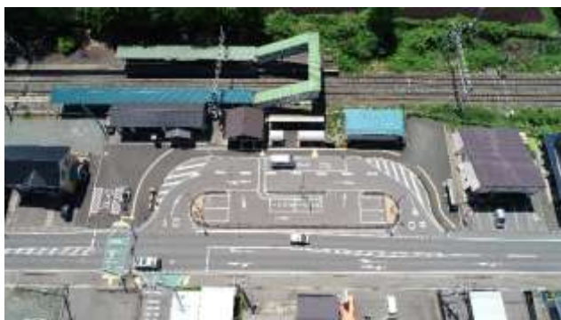
▲整備後のJR小岩井駅周辺(R6.5月撮影)
