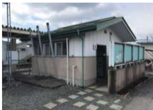
整備前〔公衆トイレ〕
