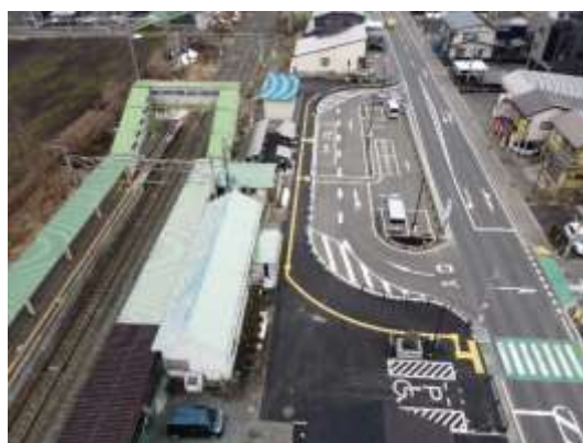
整備後(R3.2月)〔駅前広場〕
