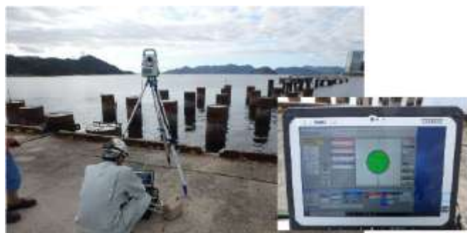
【杭打設管理システムによる三次元測定】
