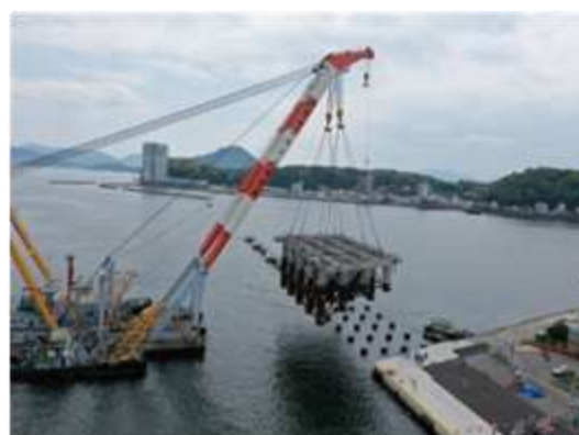
【大型起重機船による一括施工】
