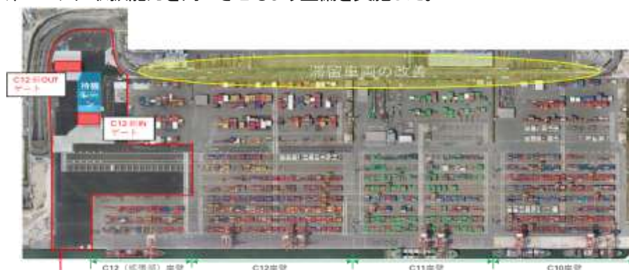
荷さばき地拡張・ゲート新設状況
