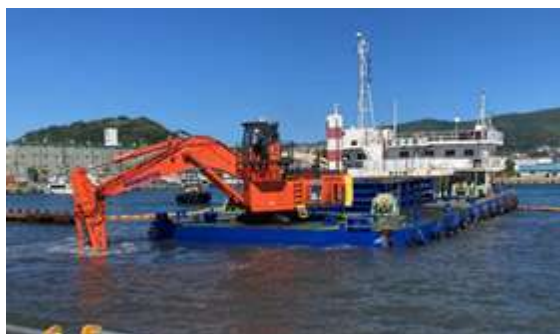
浚渫・床掘状況
