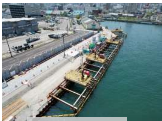
深層混合処理状況
