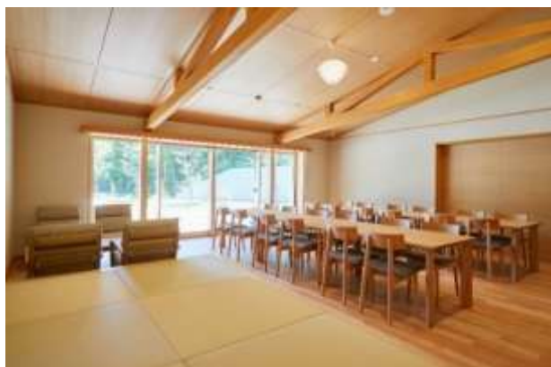
構造材及び内装材に県内産材を利用した待合室
