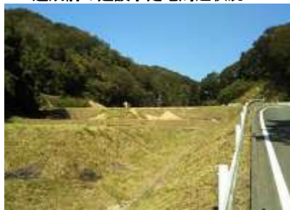
造成前の建設予定地下部からの写真
