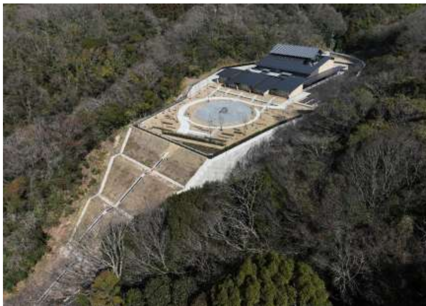
造成法面を含む敷地全景
