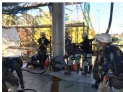
CFT 柱にコンクリートを打込む様子
