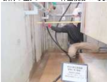
実稼働検証(水平変位の測定)
