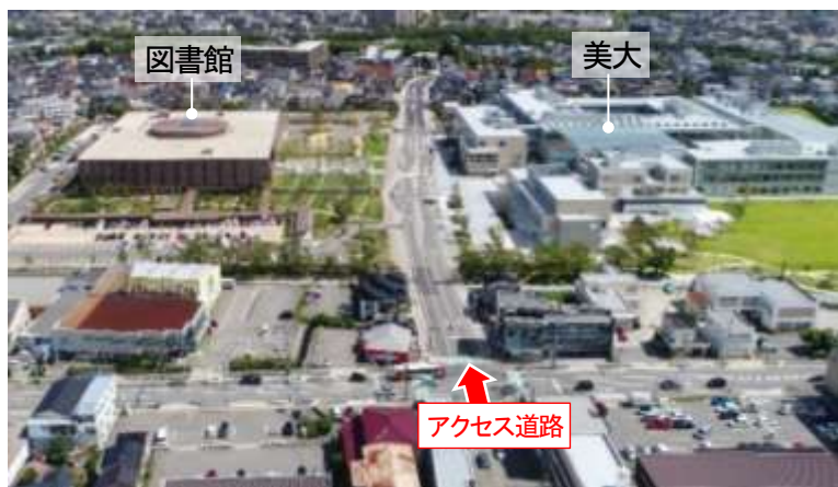
新たに整備したアクセス道路(都市計画道路)
