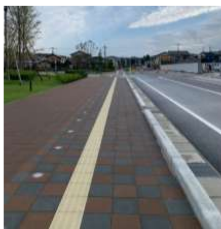
色調を調和させた歩道の舗装
