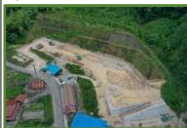
①擁壁施工状況
