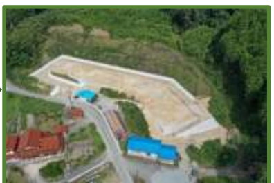
②擁壁工完成
