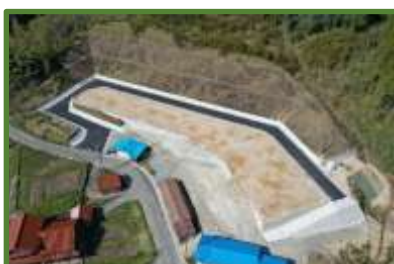
③道路工・水道工完成
