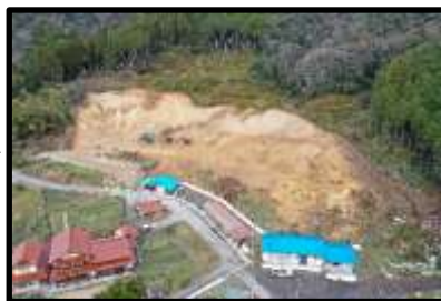
②掘削・土砂搬出状況
