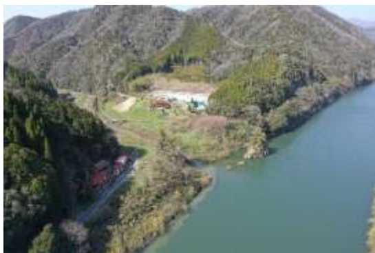
【港地区防災集団移転地と江の川】
