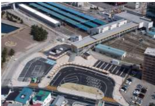
青森駅自由通路及び青森駅西口駅前広場
