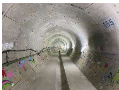
完成した昭和町雨水貯留管
