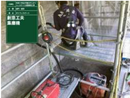
土木工事における削孔作業での集塵
