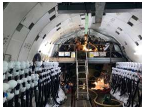
凍結工法施工状況
