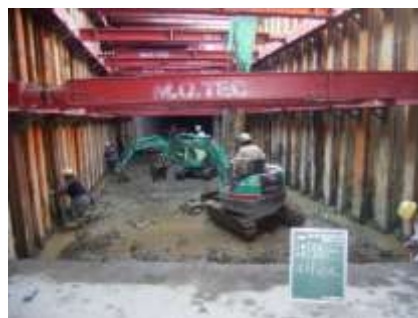
図4—2 ボックスカルバート設置前の敷均し状況
