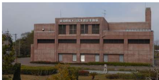
図2 青木川放水水路排水機場
