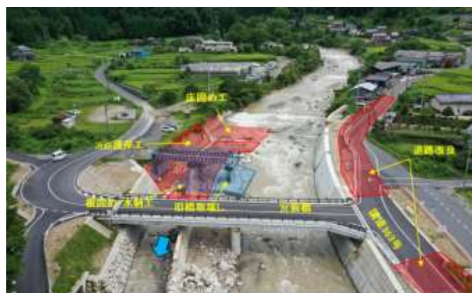
宮前堰堤の改築及び宮前橋の架け替え工事
