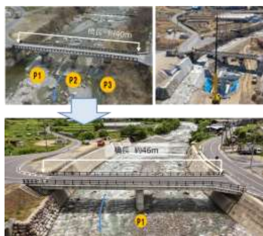
宮前橋の架け替え工事
