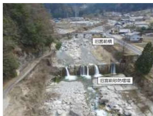
平成 29 年 工事着工前
