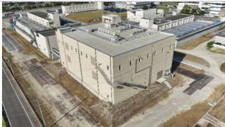
オゾン促進酸化処理施設空撮(令和6年10月撮影)
