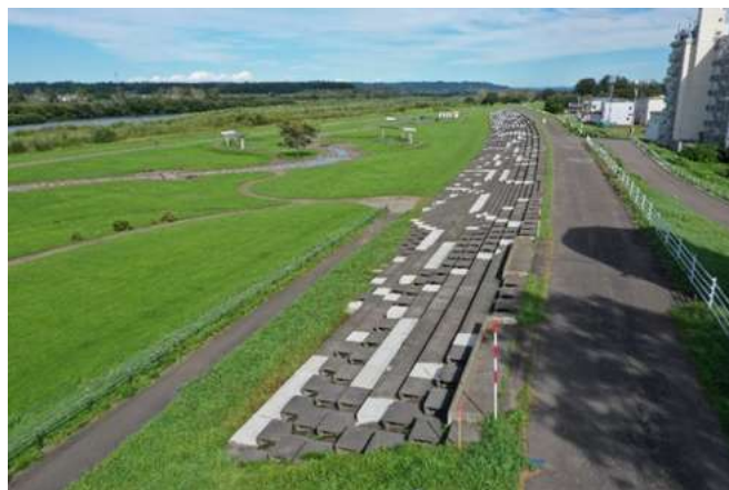
高水護岸整備(十勝川大橋下流右岸側)
