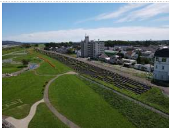
帯広地区かわまちづくり 事業エリア空撮写真(下流側)
