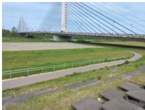
管理用通路整備(十勝川大橋上流右岸側)
