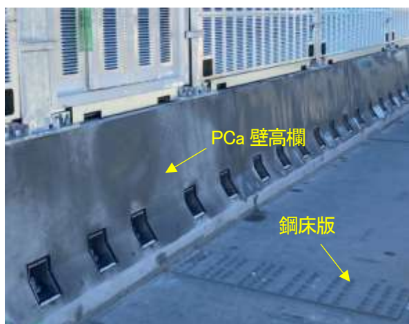
耐久性鋼床版へのPCa壁高欄設置状況と接合部構造詳細
