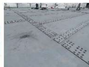
皿型高力ボルトの構造詳細と接合状況
