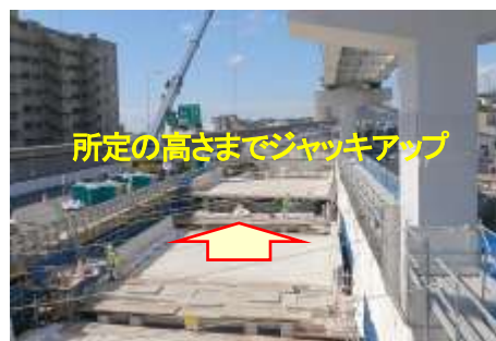
ジャッキアップ工法の施工状況写真
