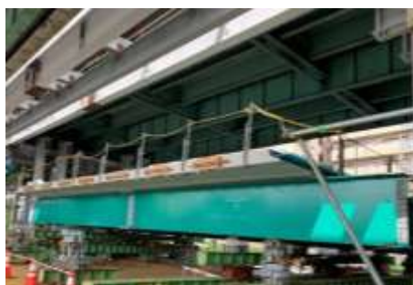
ジャッキアップ工法の施工状況写真
