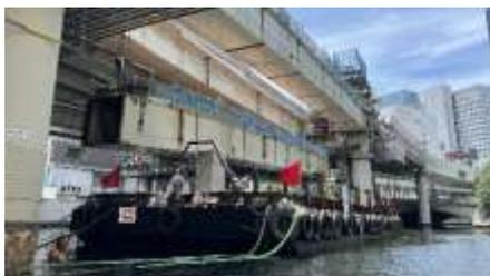
図-5 油圧ジャッキによる台船への桁降下状況
