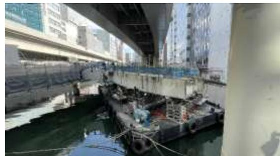
図-7 潮位変動を利用した桁撤去状況
