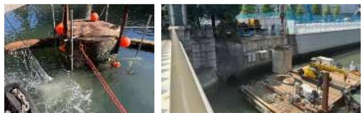
図-8 河川内の橋脚撤去状況
