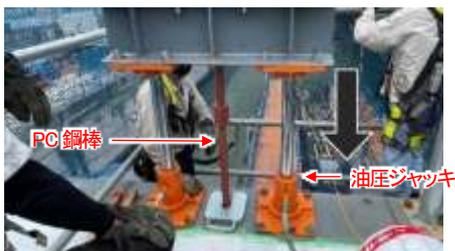
図-4 油圧ジャッキ操作状況
