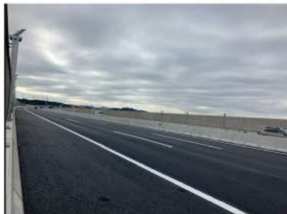
床版取替工事後
