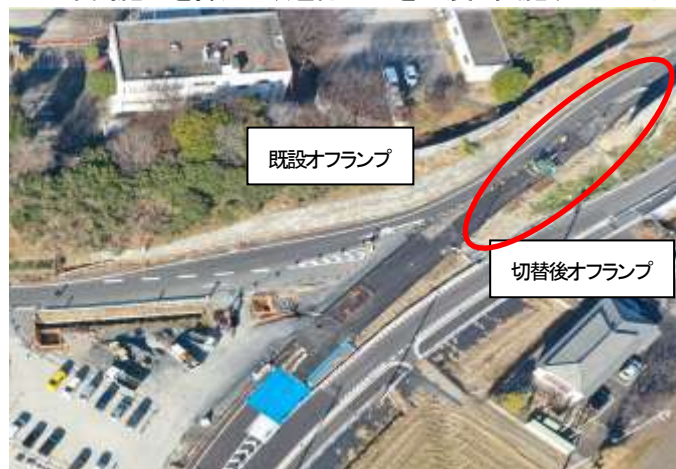
上り線オフランプ半割施工状況
