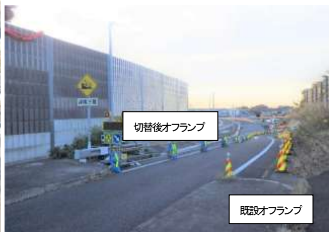
上り線オフランプ半割施工状況
