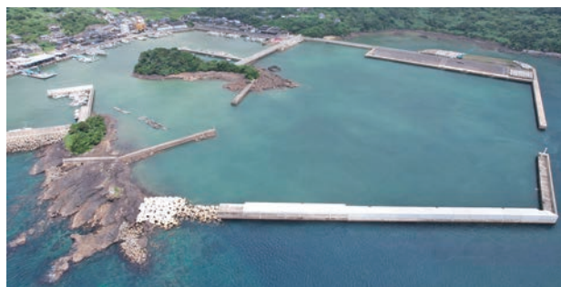
復旧工事完了後
