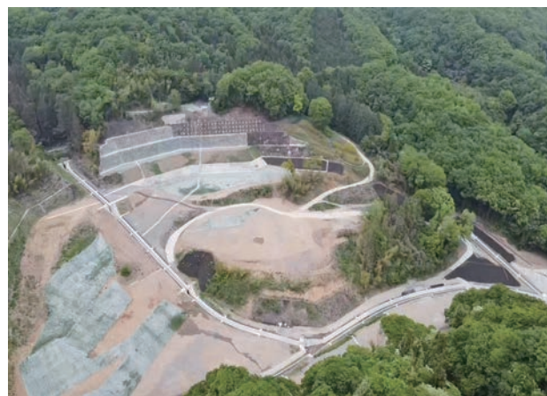
完成後の写真
