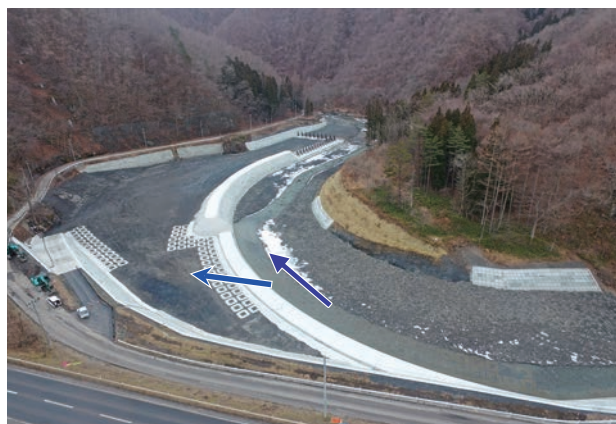
流木捕捉施設全景
